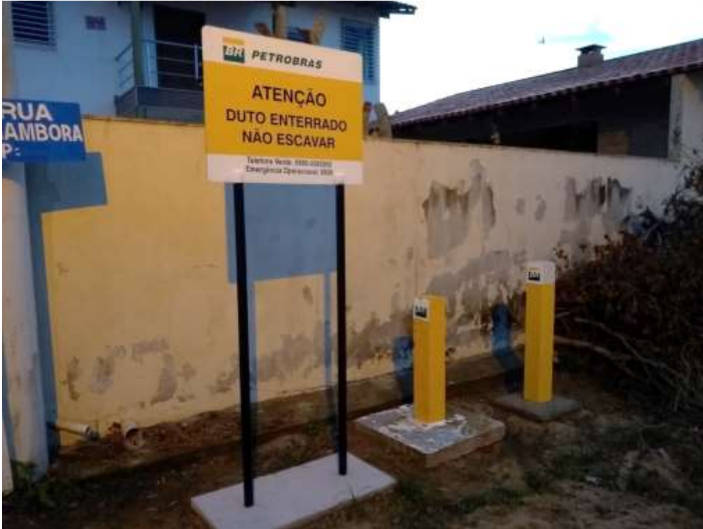
Figura 15 – Placa de indicação da presença de duto enterrado em uma rua na comunidade de Barra Seca
