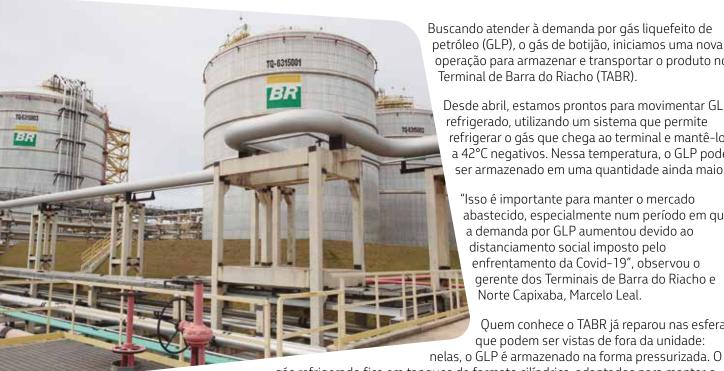
Buscando atender à demanda por gás liquefeito de petróleo (GLP), o gás de botijão, iniciamos uma nova operação para armazenar e transportar o produto no Terminal de Barra do Riacho (TABR).
