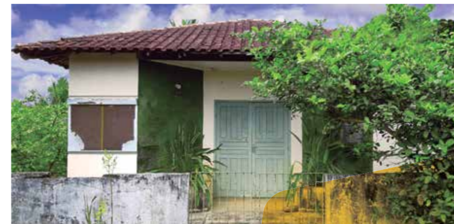
Centro de Convivência de Chapada do Á (Anchieta), que será reformado
